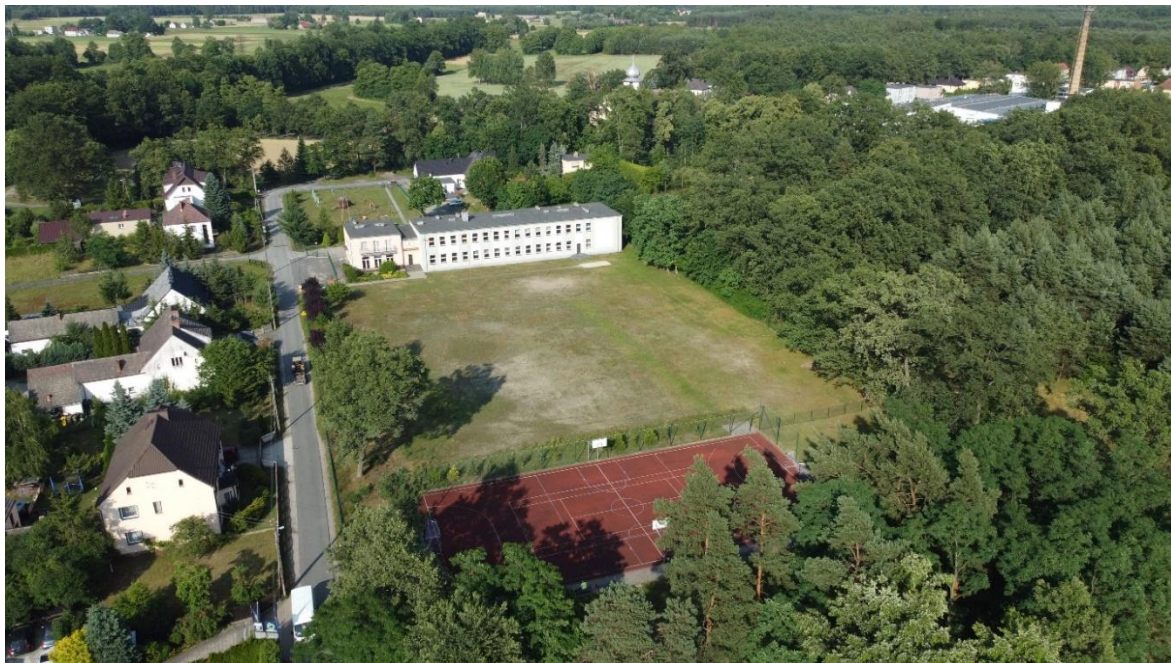
Ryc. 7 Teren objęty postanowieniami projektu miejscowego planu zagospodarowania przestrzennego części wsi Dylaki (wskazany na załączniku nr 2 do projektu planu)
